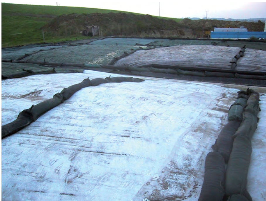
Рис. 21. Силосные мешки с гравием применяются в качестве уплотняющего средства, и должны укладываться на расстоянии 5–8 м. Хорошее укрытие сопровождается образованием пленочного колпака для бродительных газов, который со временем исчезает. Прокалывать его строго запрещается.
